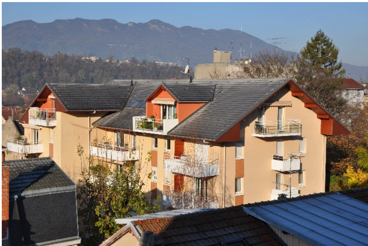
Vue depuis l'arrière
