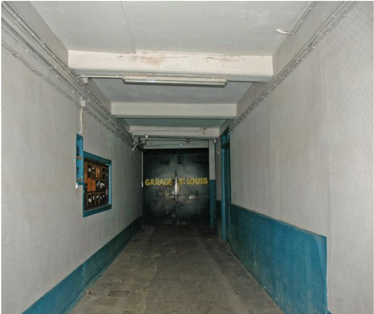
Passage couvert vue depuis l'ouest
