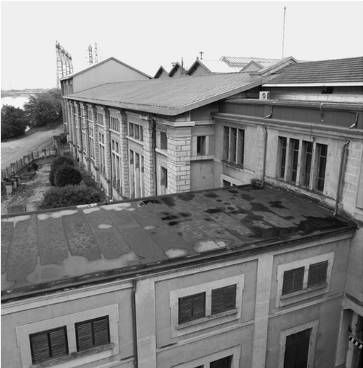
Centrale thermique, vue nord
