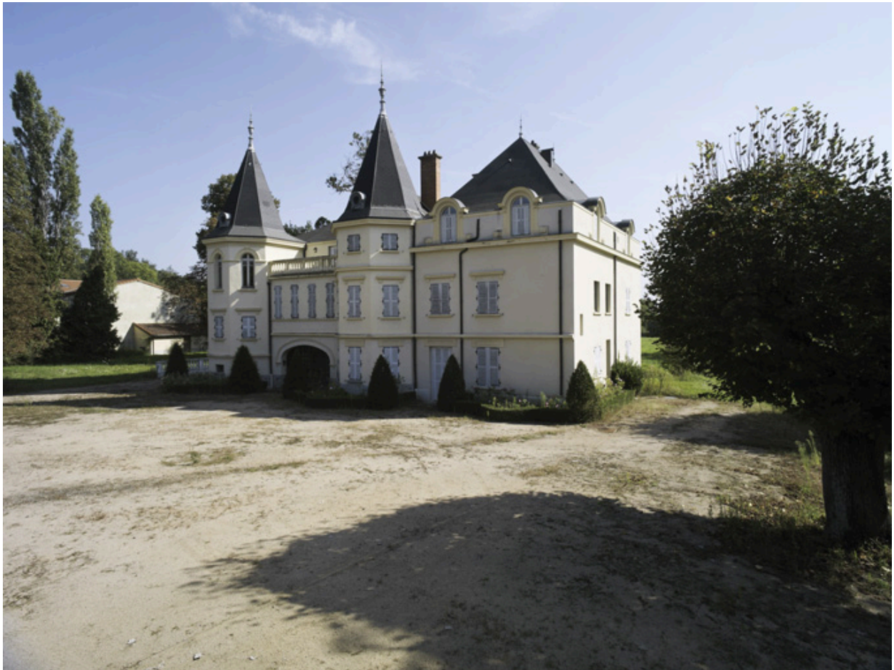
Vue d'ensemble de la demeure, depuis le sud-ouest.
