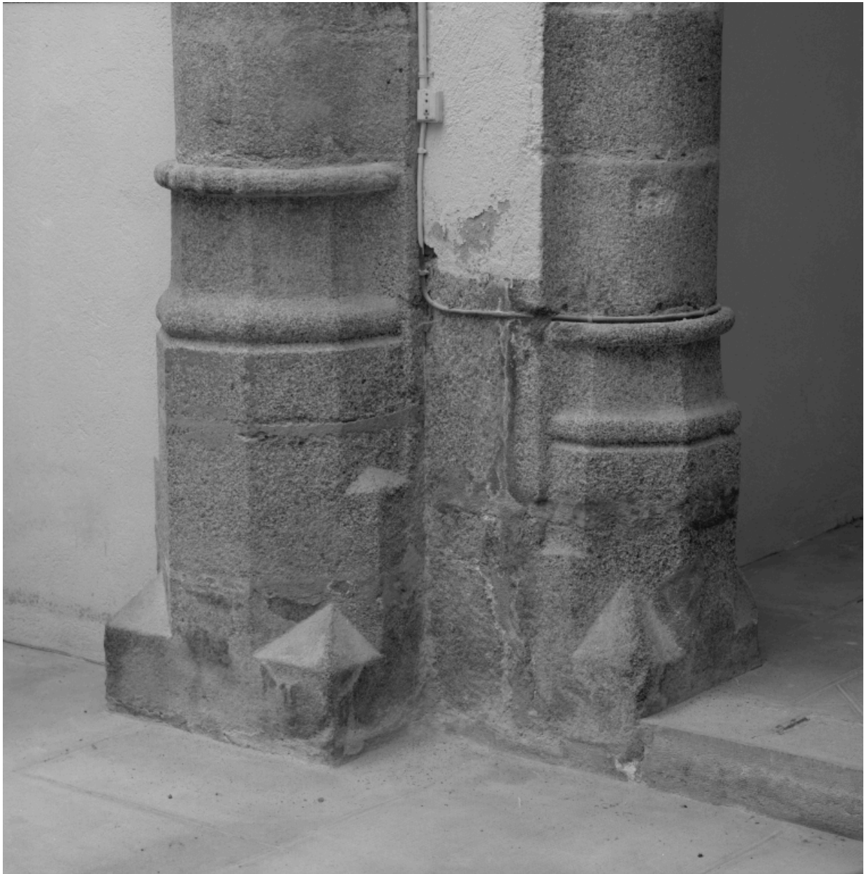
Vue intérieure, détail de la base du troisième pilier nord.
