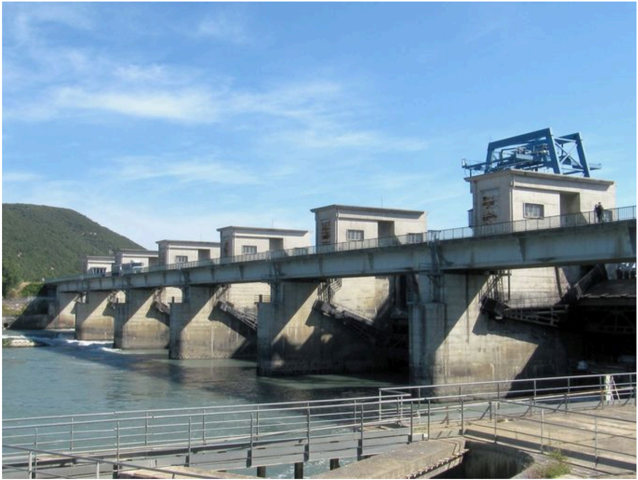
Vue générale, face aval (depuis la rive gauche)
