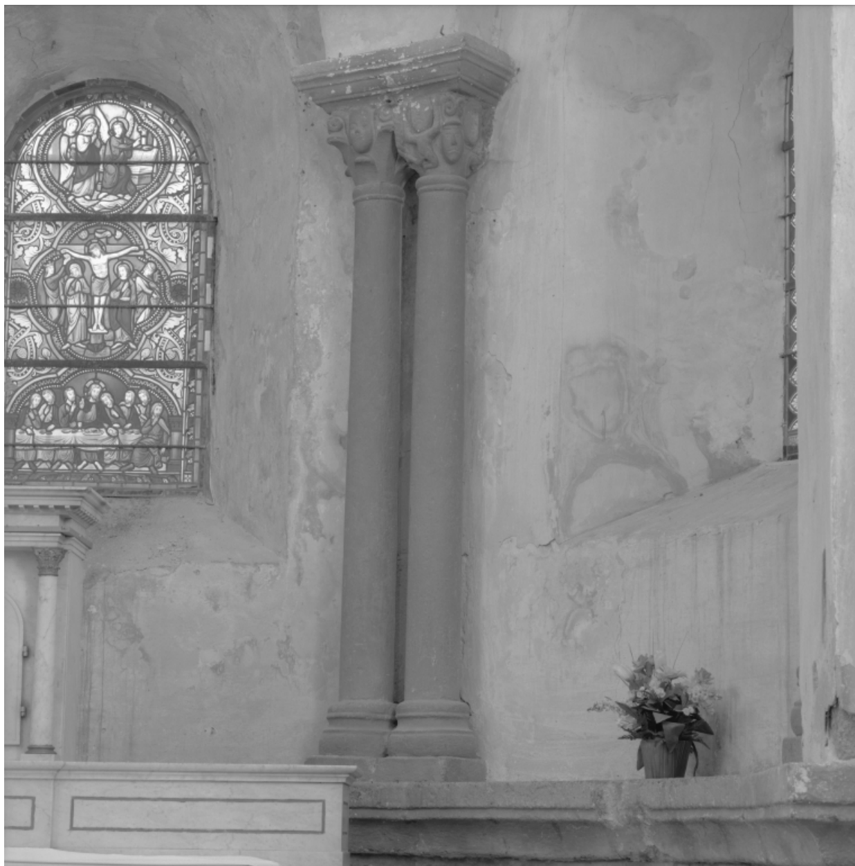
Vue d'ensemble des colonnettes géminées et de leurs chapiteaux (n°4, 5).
