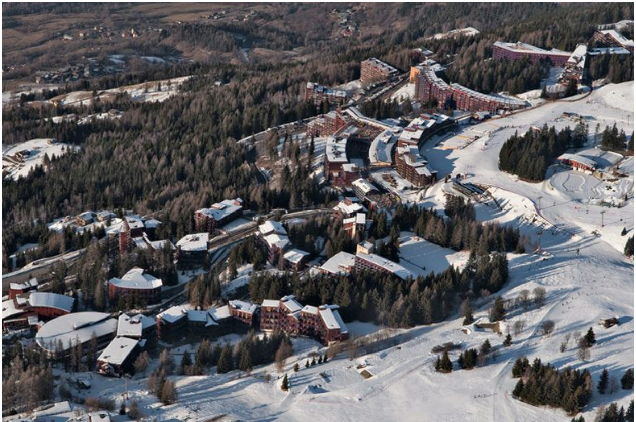
Vue aérienne depuis le sud. Charmettoger, les Villards, Charvet
