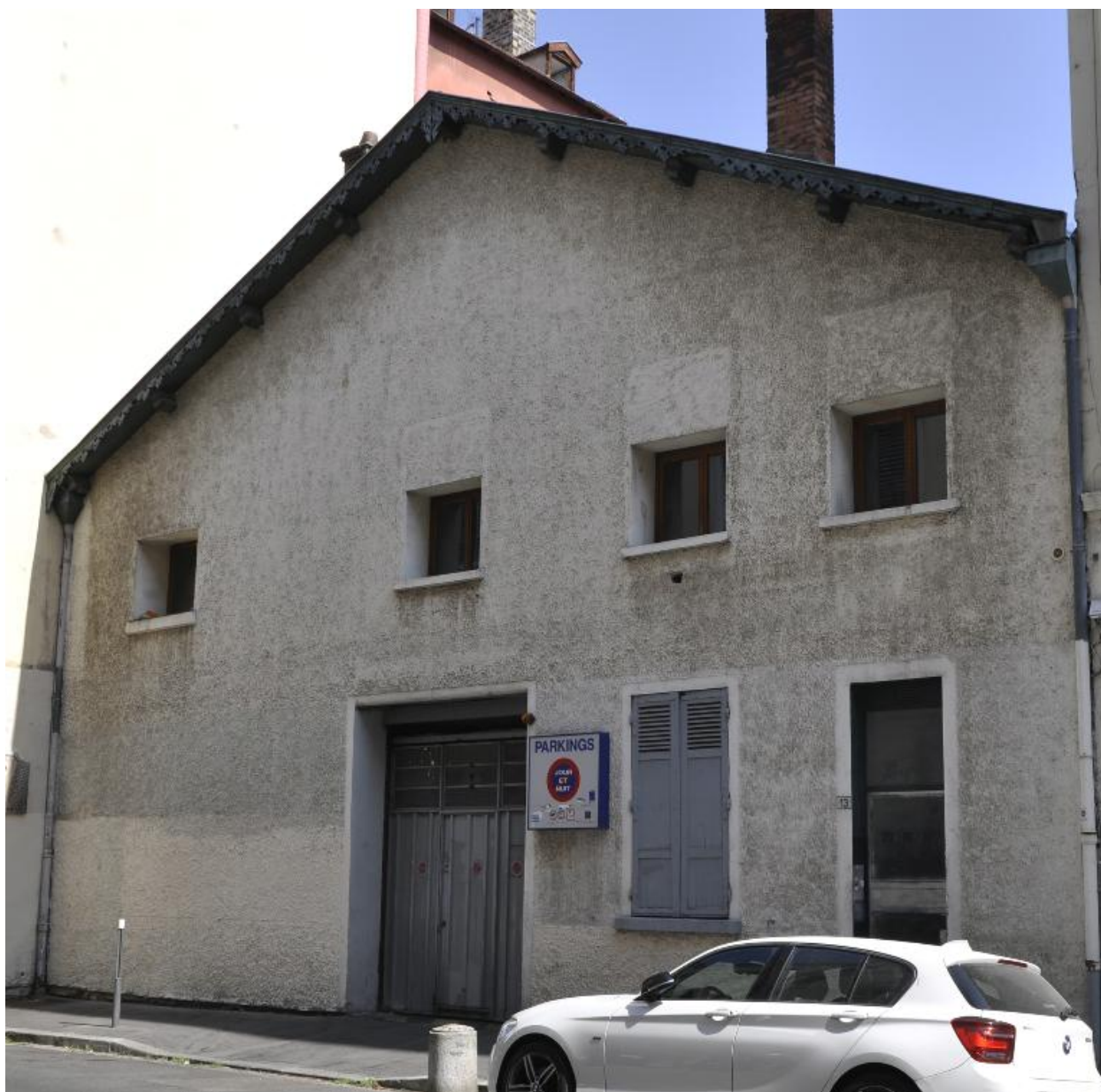
Vue générale de l'élévation sur rue
