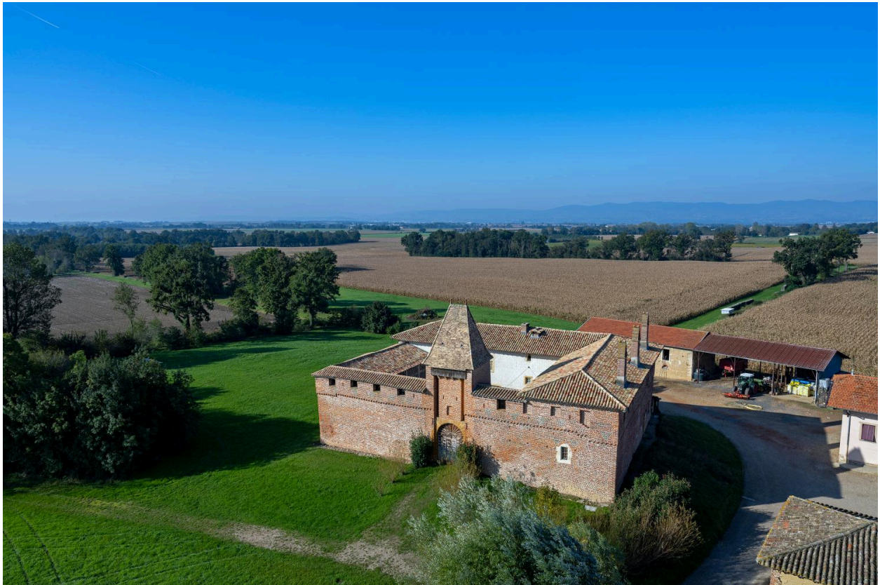
Vue aérienne, depuis le nord-est
