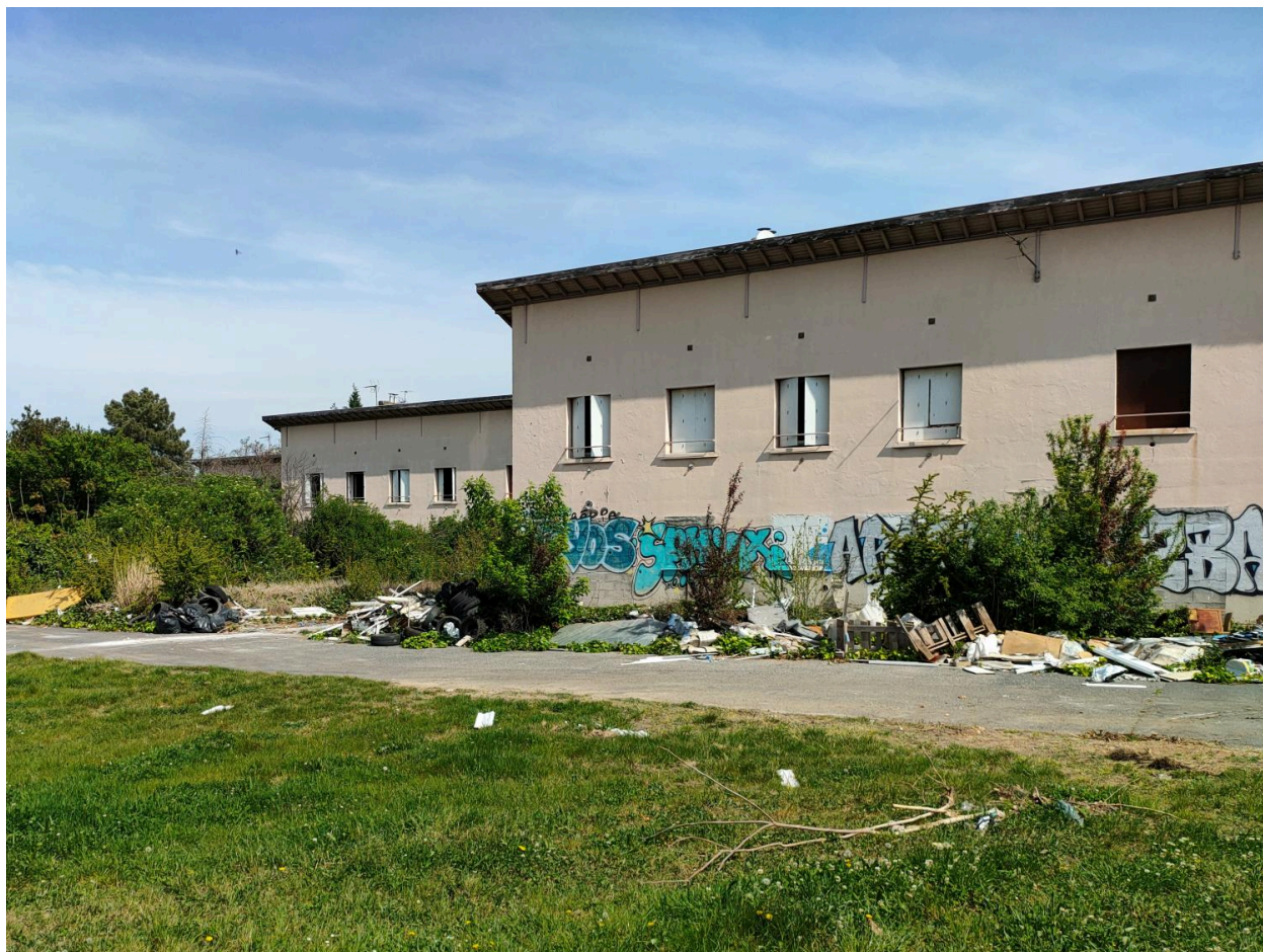
Cité ouvrière P.L.M. dite Coblod - vue depuis le pont Berliet
