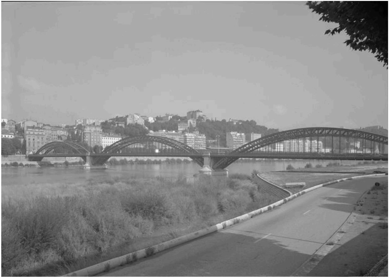
Vue rapprochée du pont avant sa destruction
