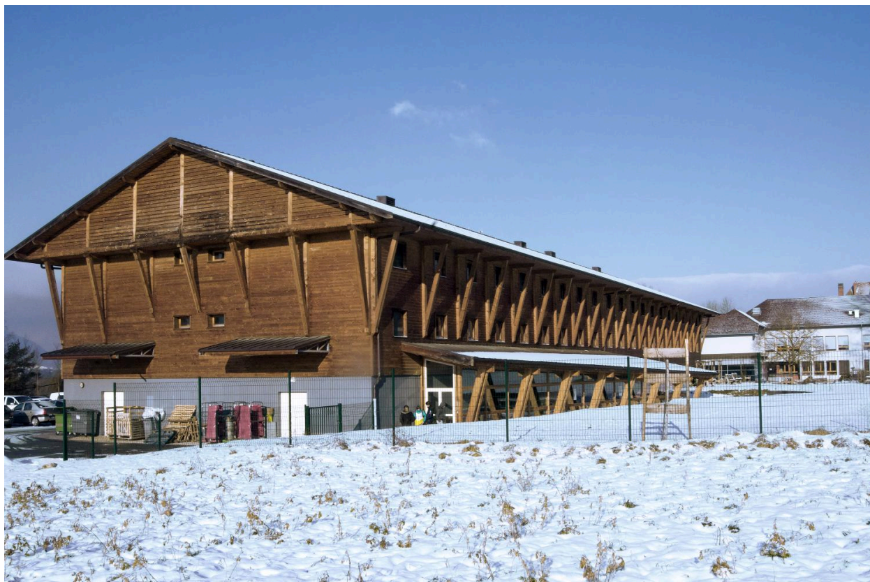
Bâtiment de l'internat, depuis le sud-ouest ; au rez-de-chaussée, réfectoire
