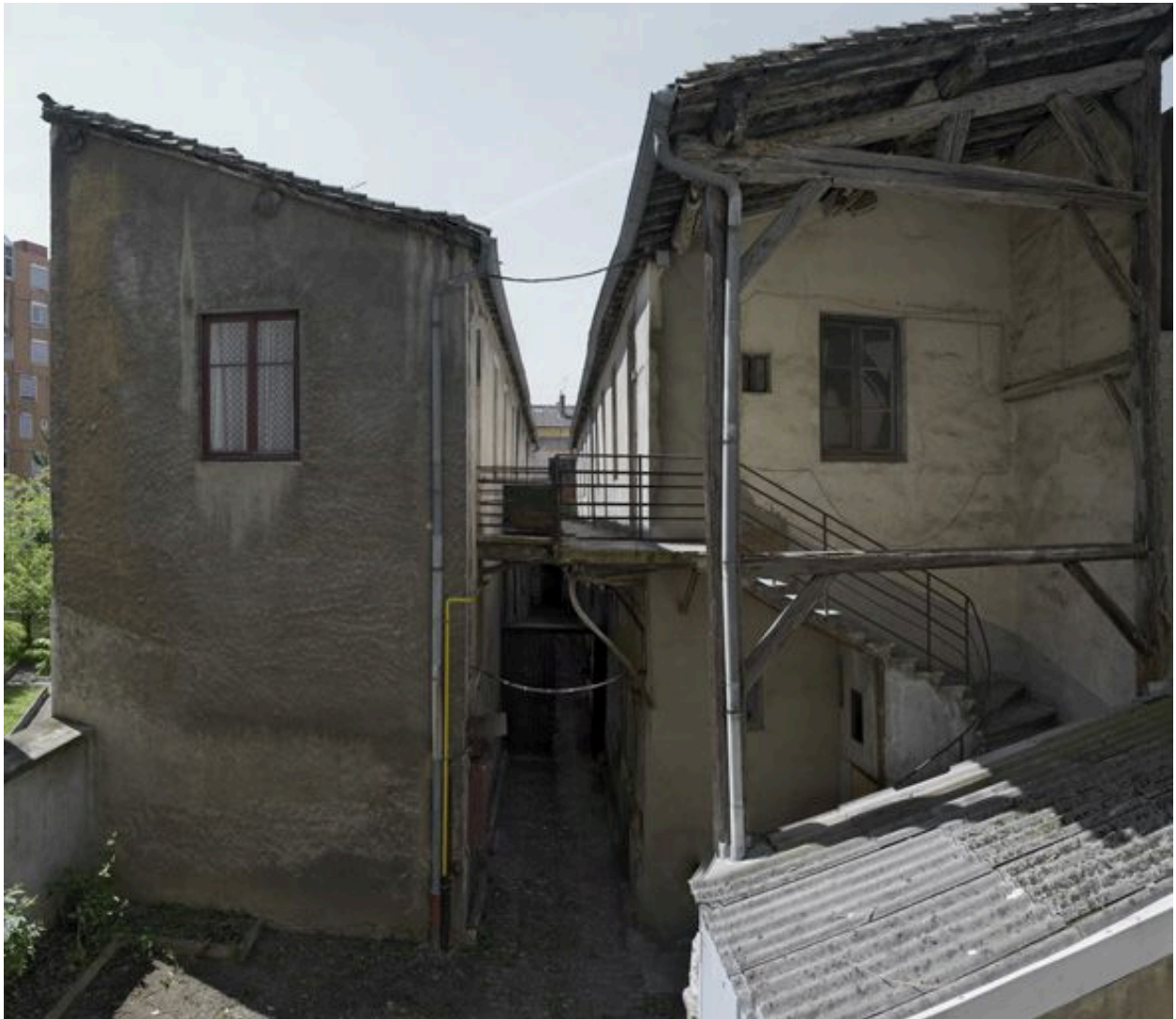
Vue générale depuis le nord
