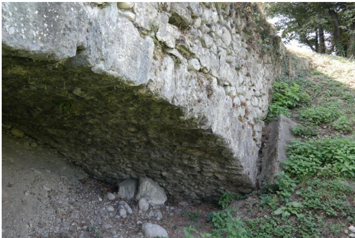
Ancien pont de Dranse, détail d'une voûte
