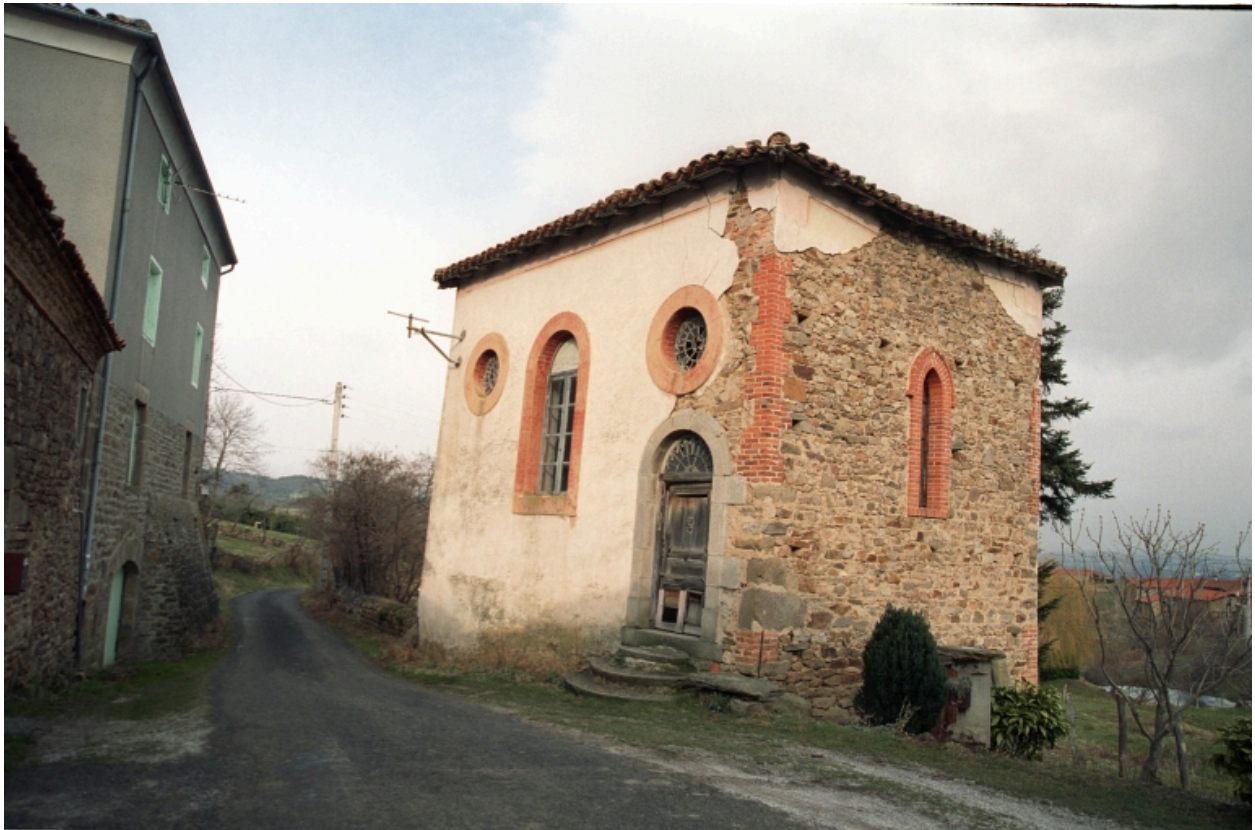
Vue d'ensemble de la chapelle depuis le sud-est (mars 2001, avant restauration).
