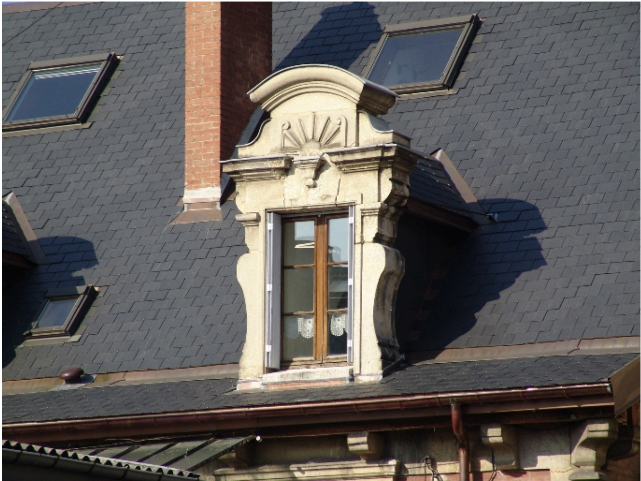
Détail d'une lucarne postérieure
