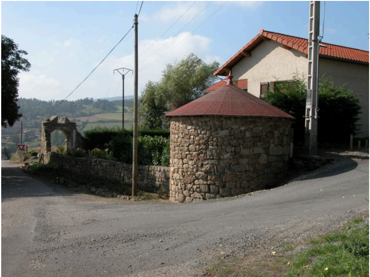
Vue d'ensemble d'une petite tour d'angle au nord-est de l'enceinte du château
