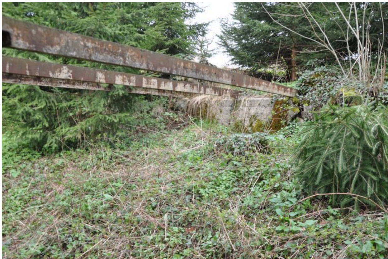
Strucure métallique de l'ancienne passerelle enjambant le bief du moulin
