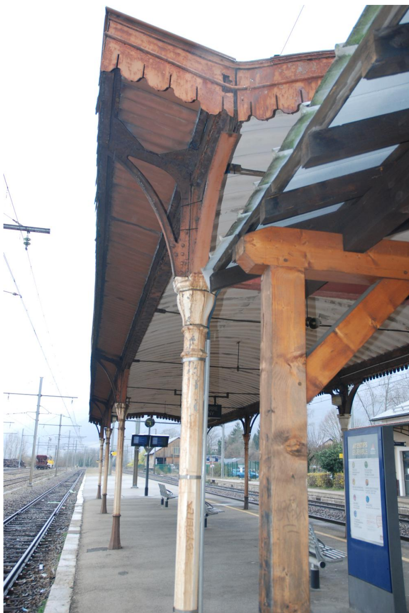
Gare de Saint-Pierre-d'Albigny : l'abri parapluie sur le quai voyageurs, détail (état en mars 2018).
