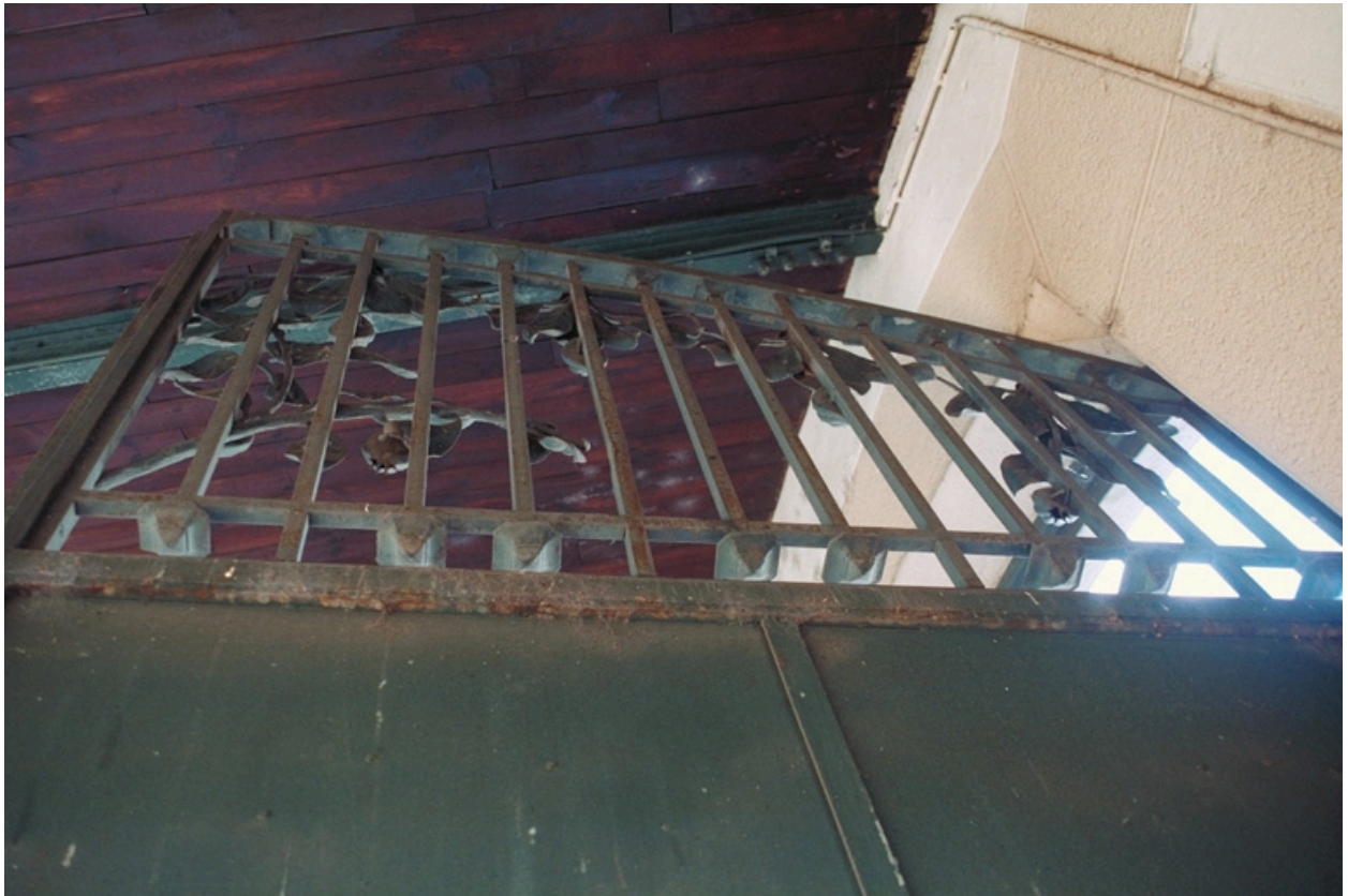
Vue arrière du portail, ferronnerie
