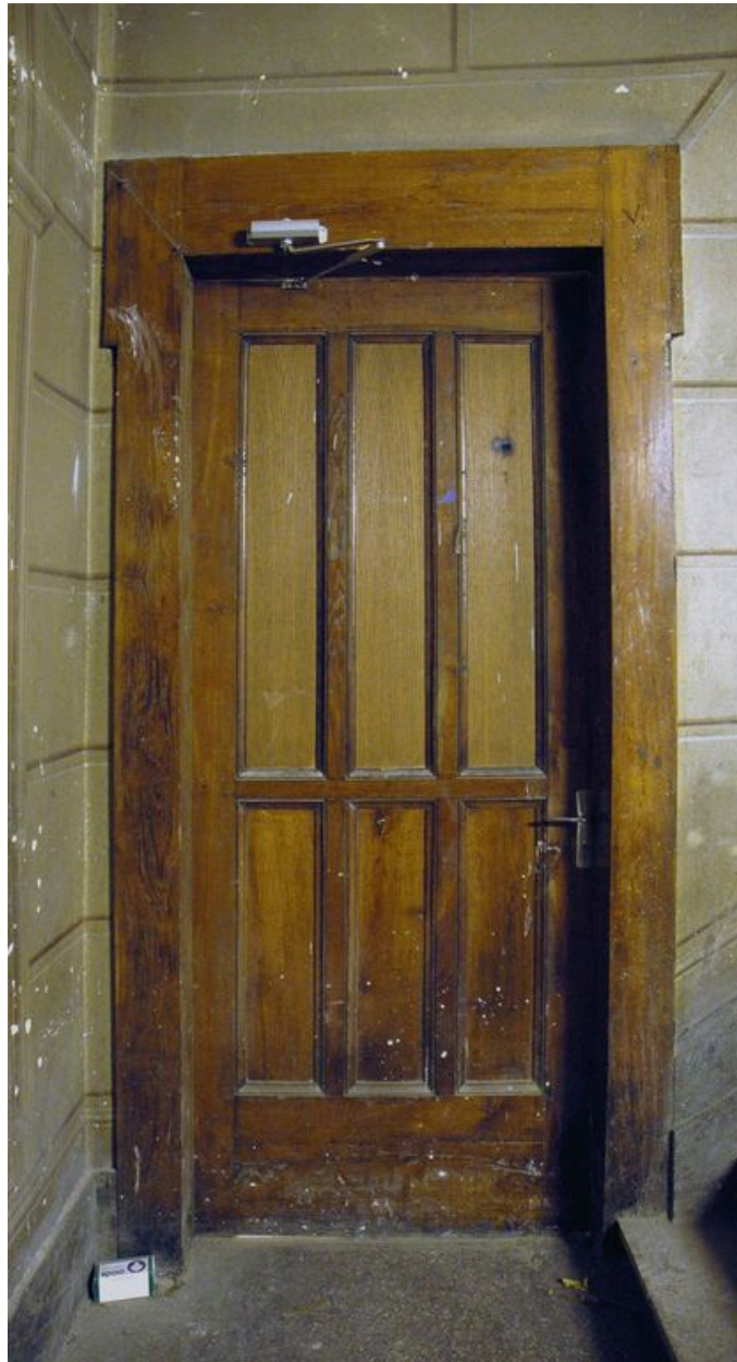
Cage de l'escalier ouest, porte d'accès à la cave ouest
