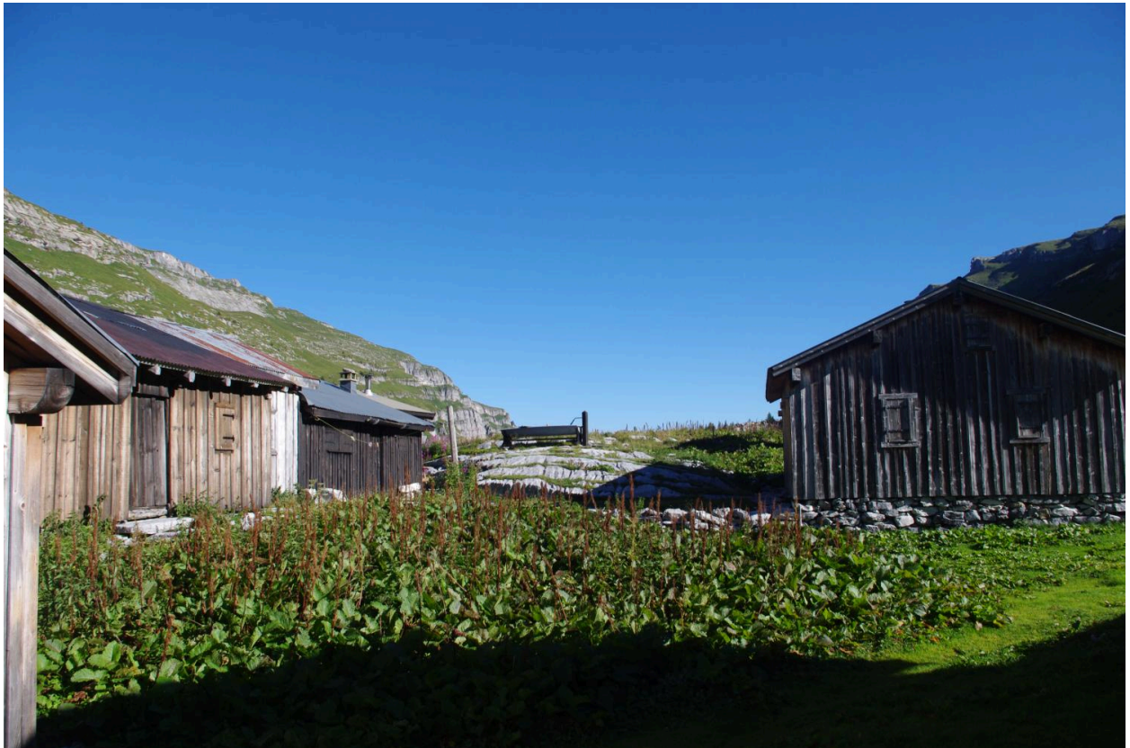
Autre vue du mur pignon sud
