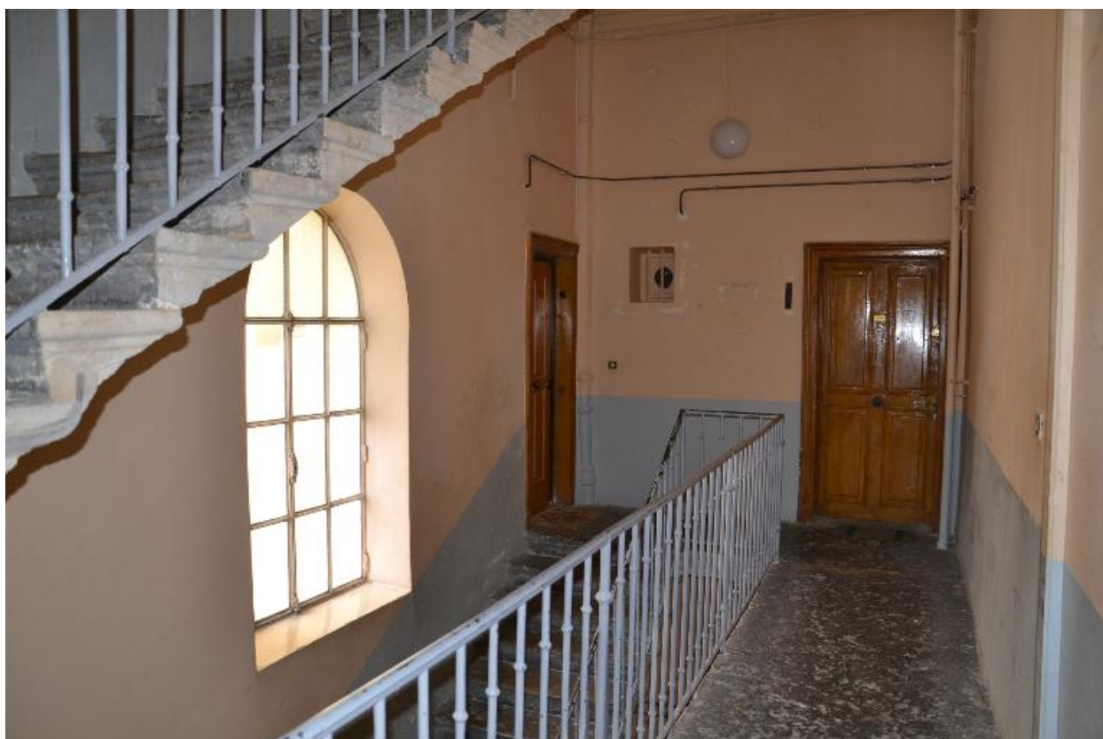
Escalier et palier
