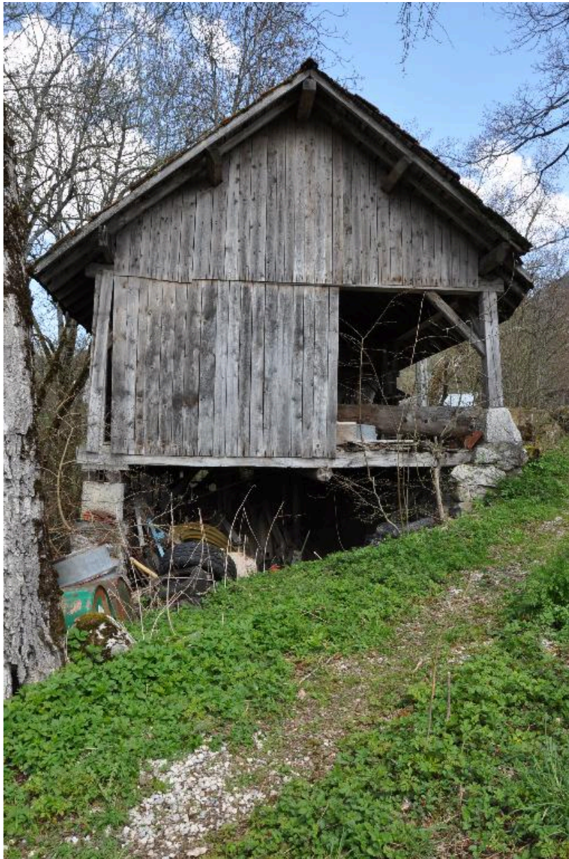
Vue du pignon sud-ouest de la scierie.
