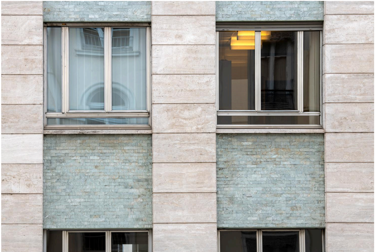
Etages carrés : traitement de la façade
