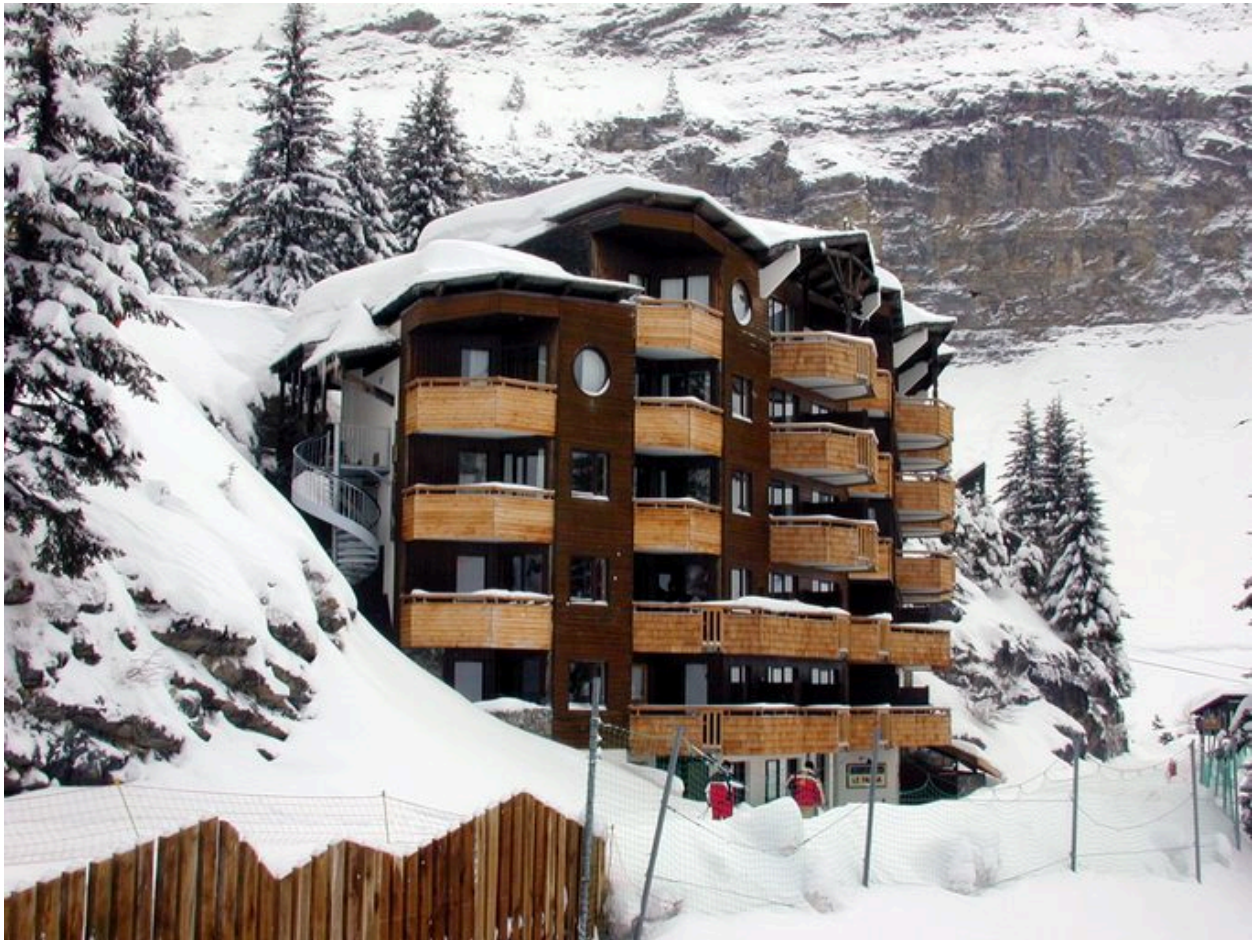
Vue depuis le sud-ouest
