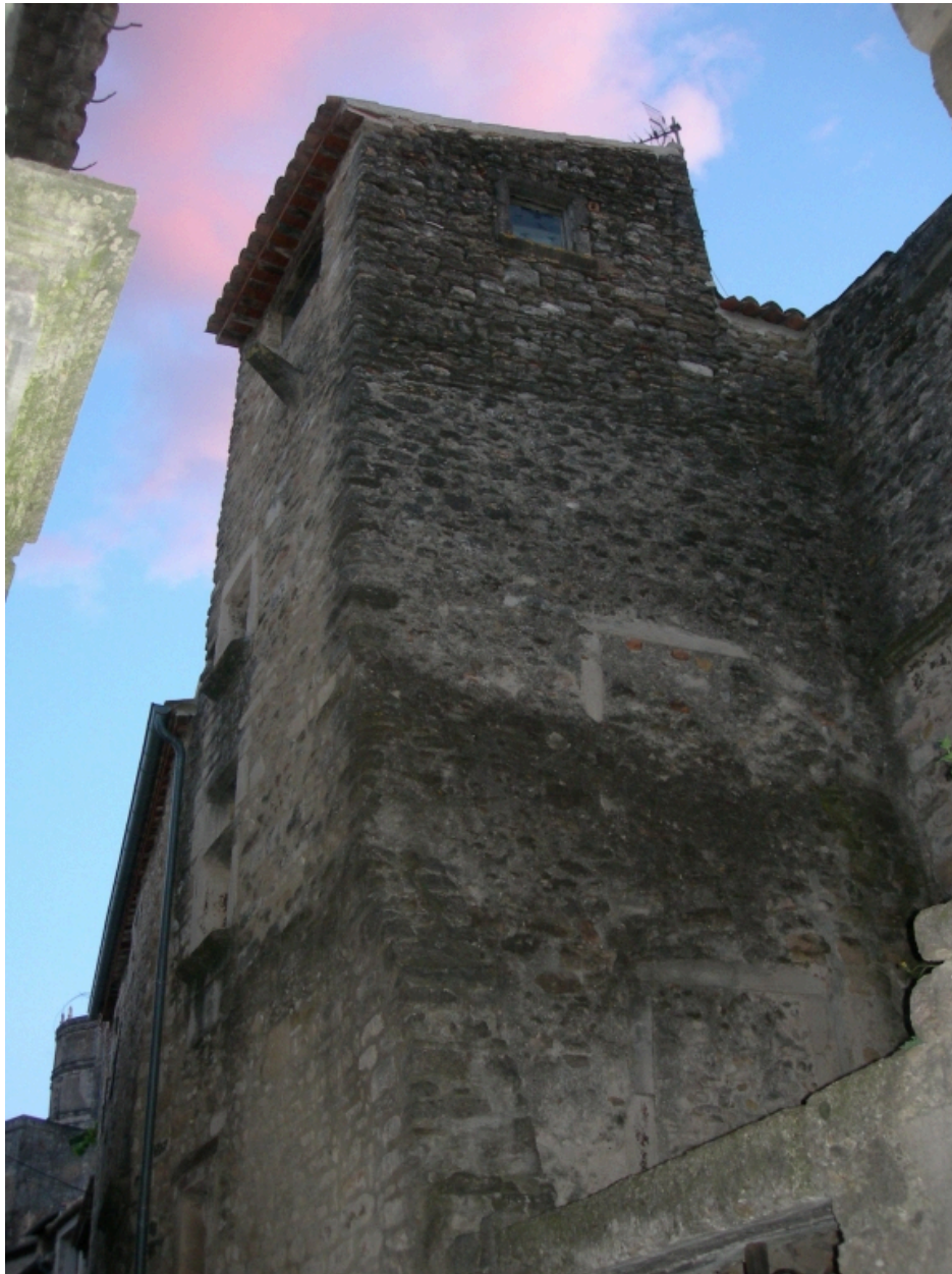
Façade sur rue : tour d'escalier, vue prise du nord.
