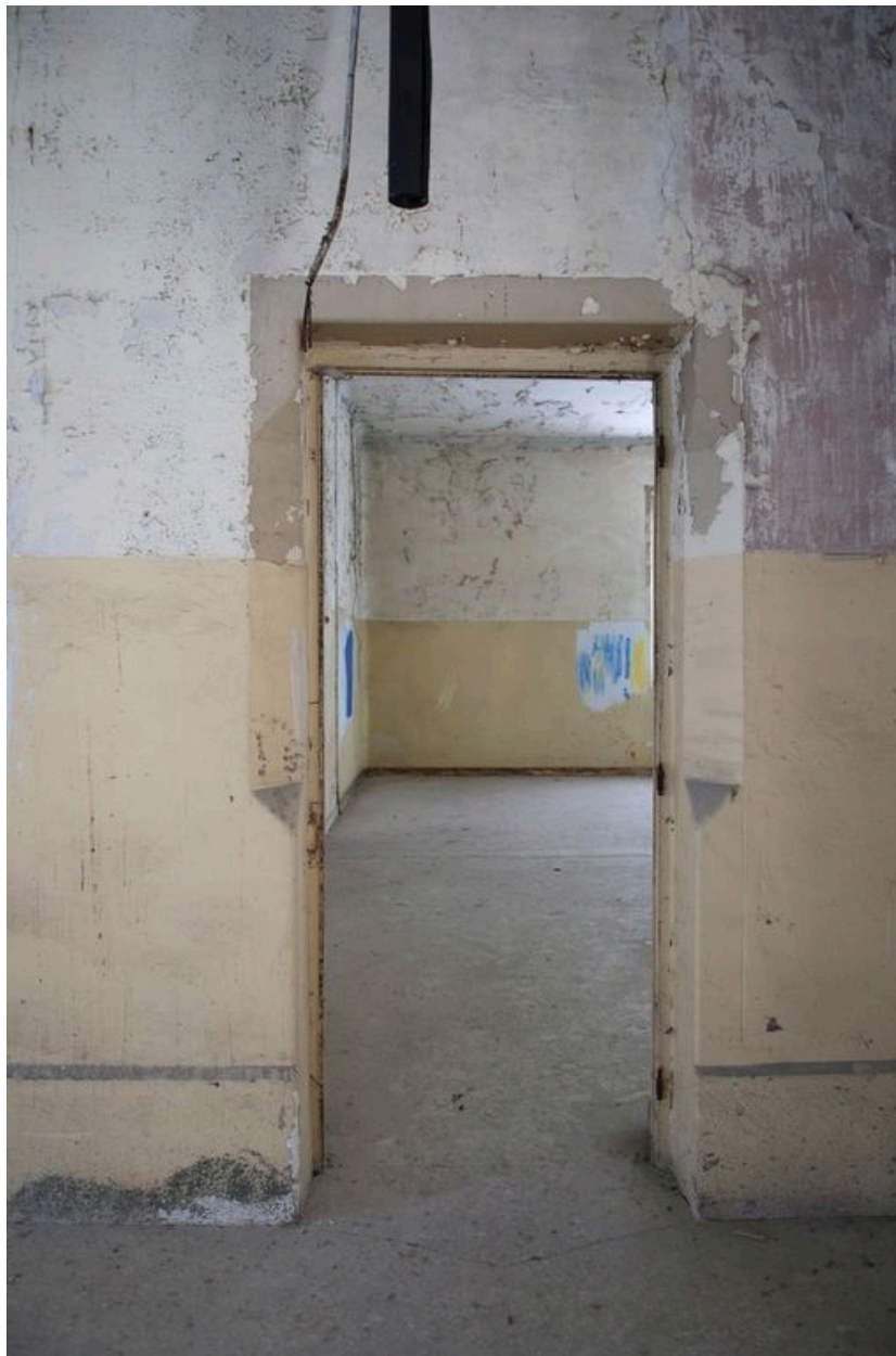
Encadrement de porte, second étage, salles désaffectées
