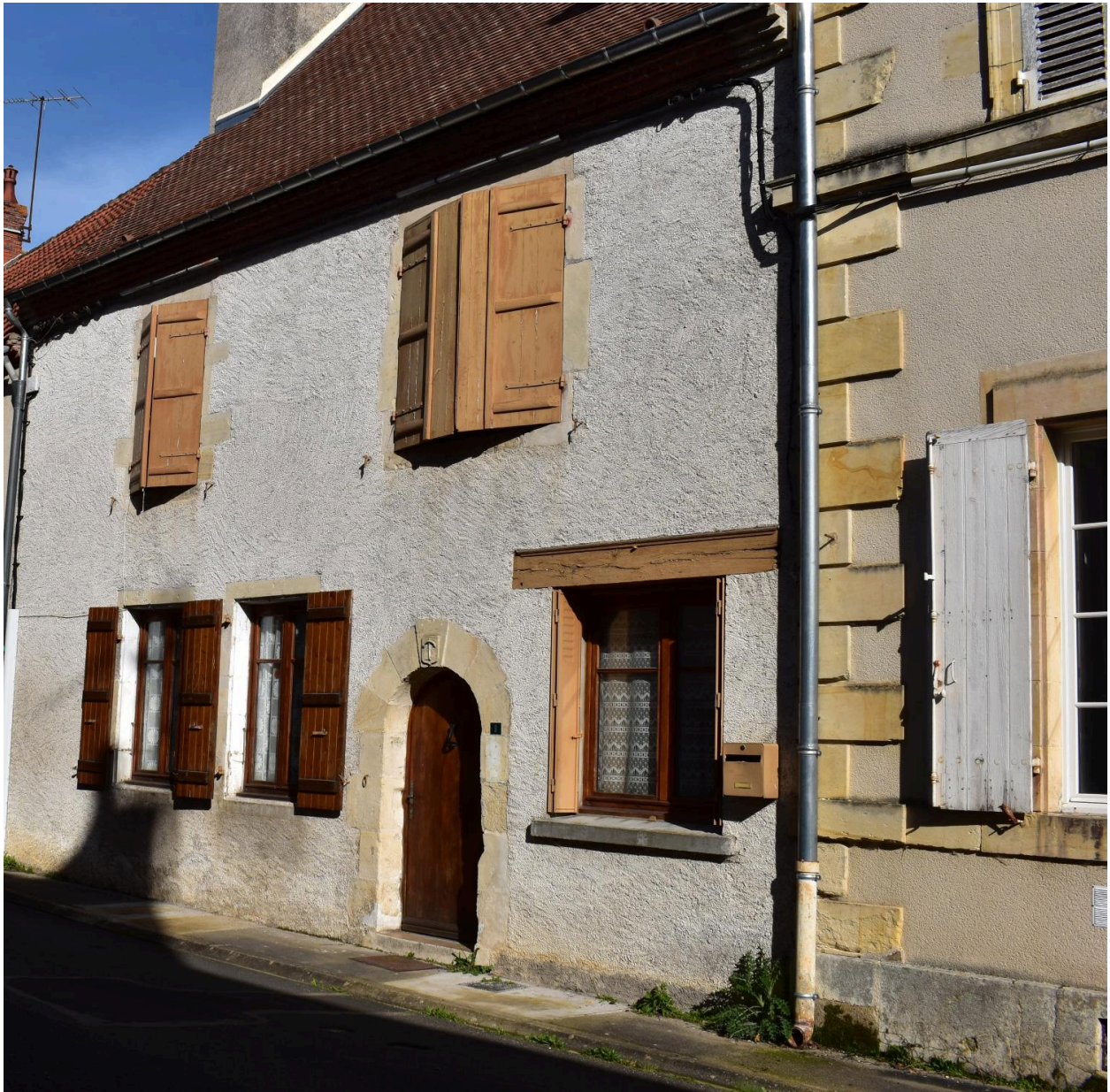
Maison, 9, rue Bourbon. Parcelle cadastrale B01 : 138, vue générale de la façade.
