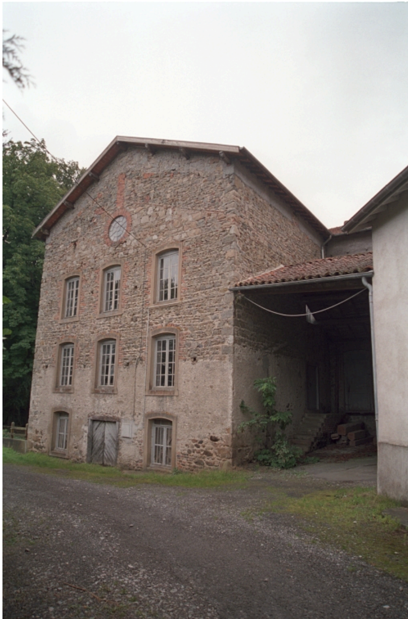
Vue d'ensemble de la façade principale du moulin.
