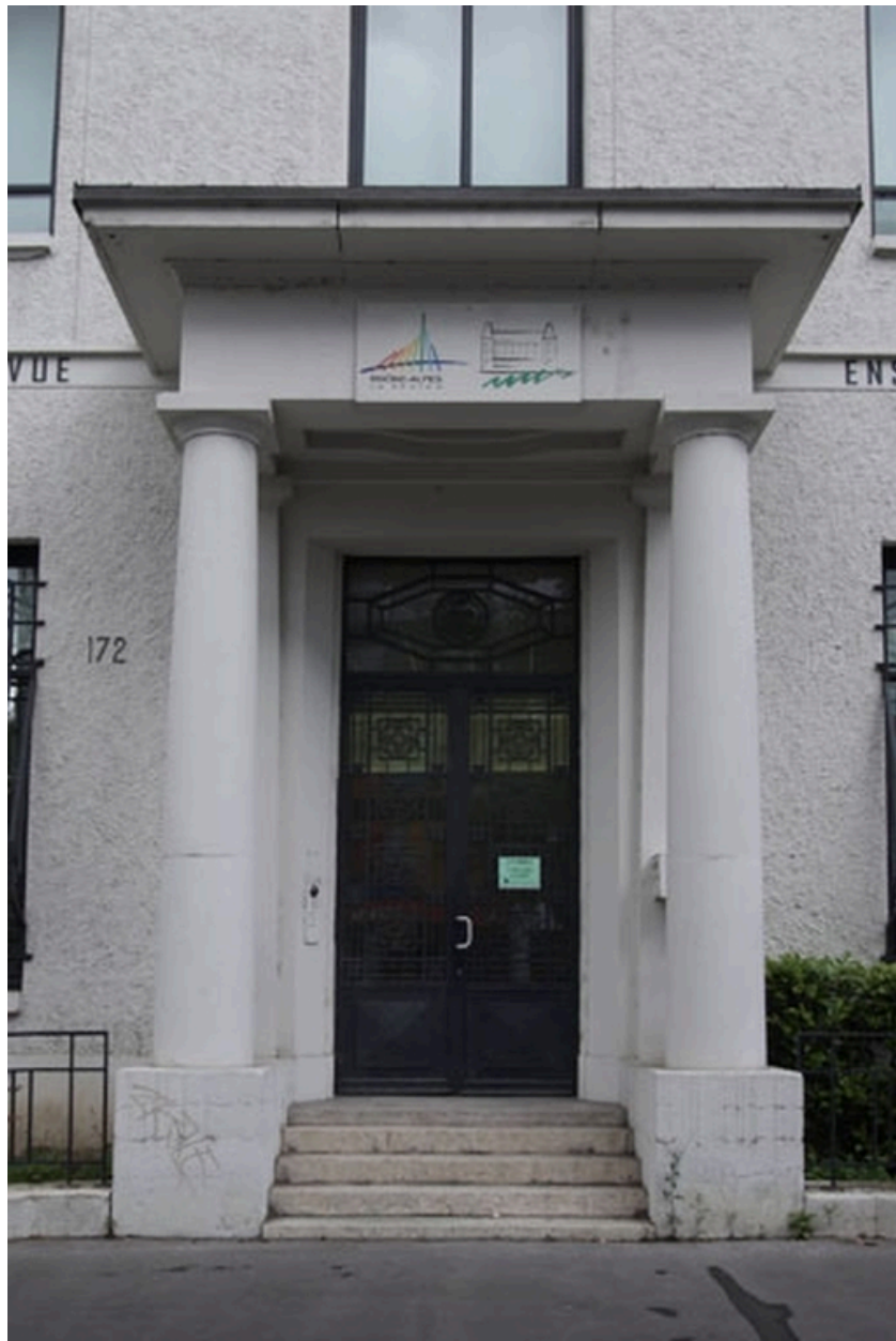
Entrée principale du bâtiment administratif
