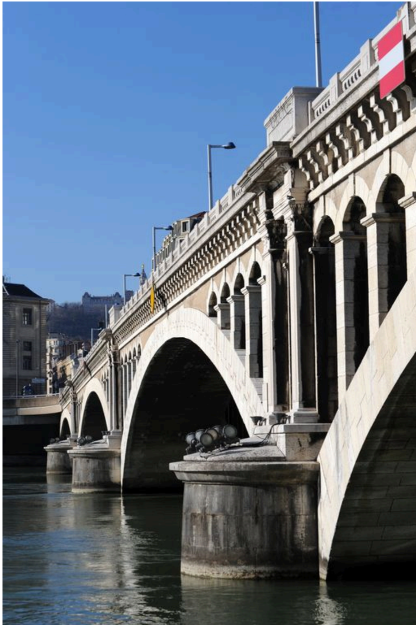
Vue partielle, de côté, face aval (depuis la rive gauche)
