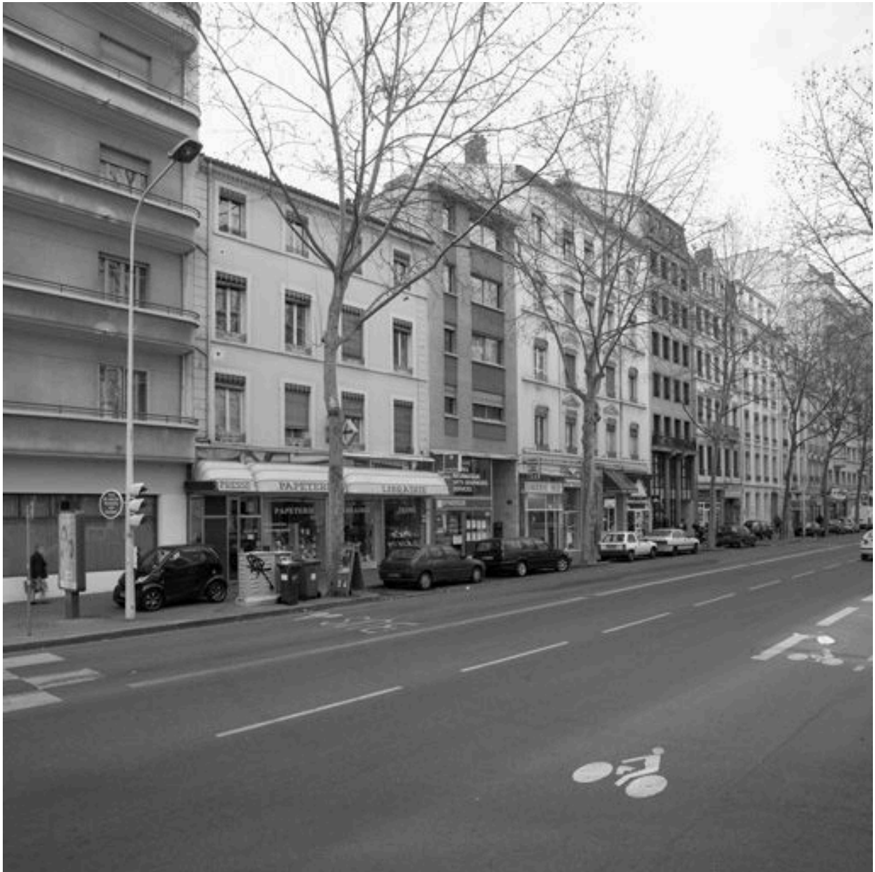
Vue générale depuis l'est
