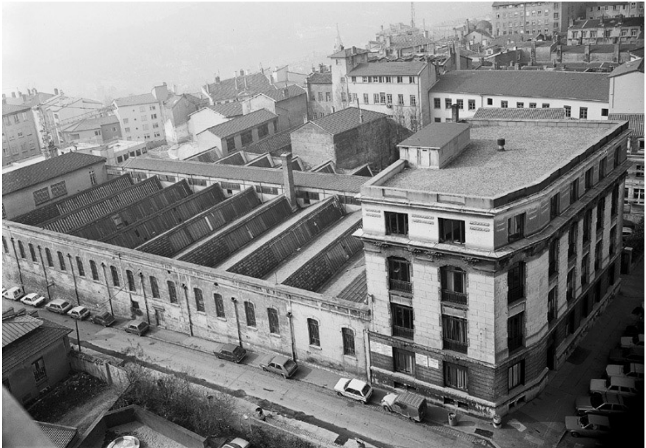
Vue générale de l'usine
