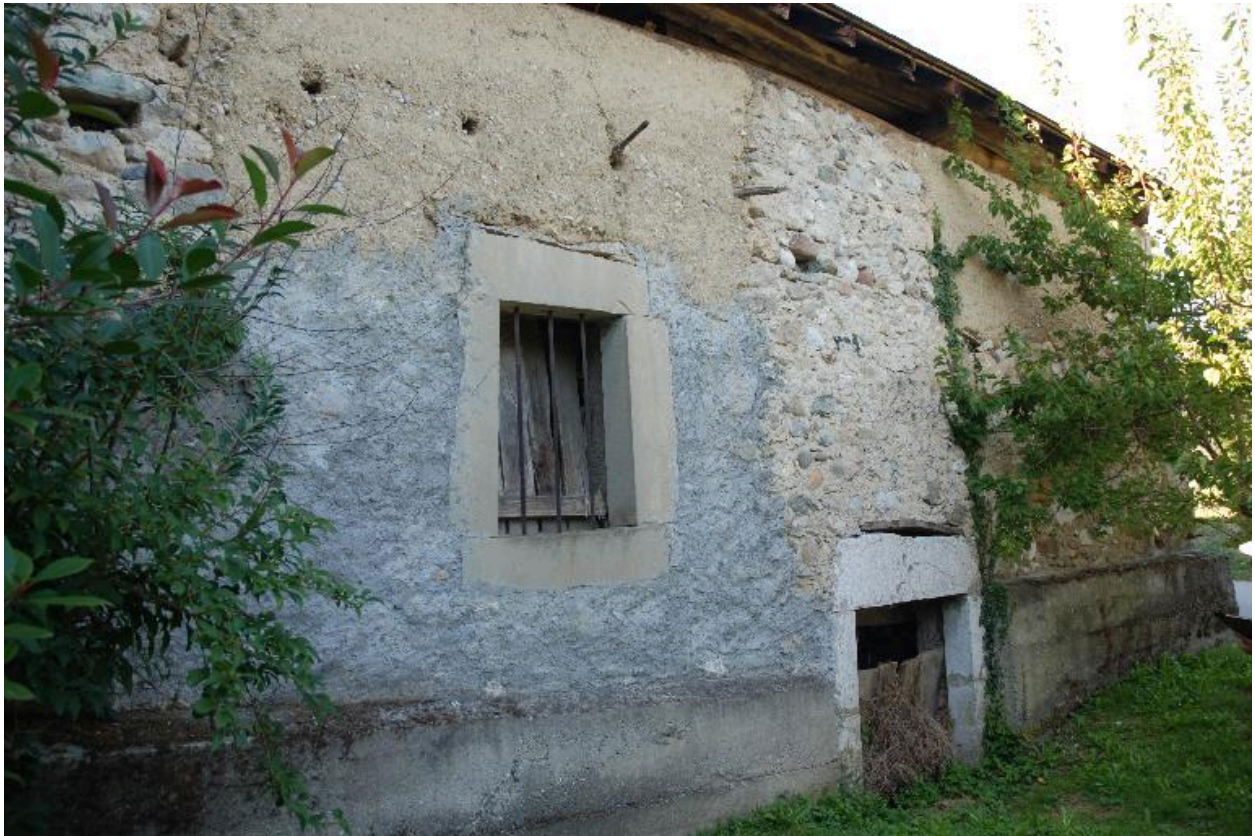
Grange-étable, vue arrière.
