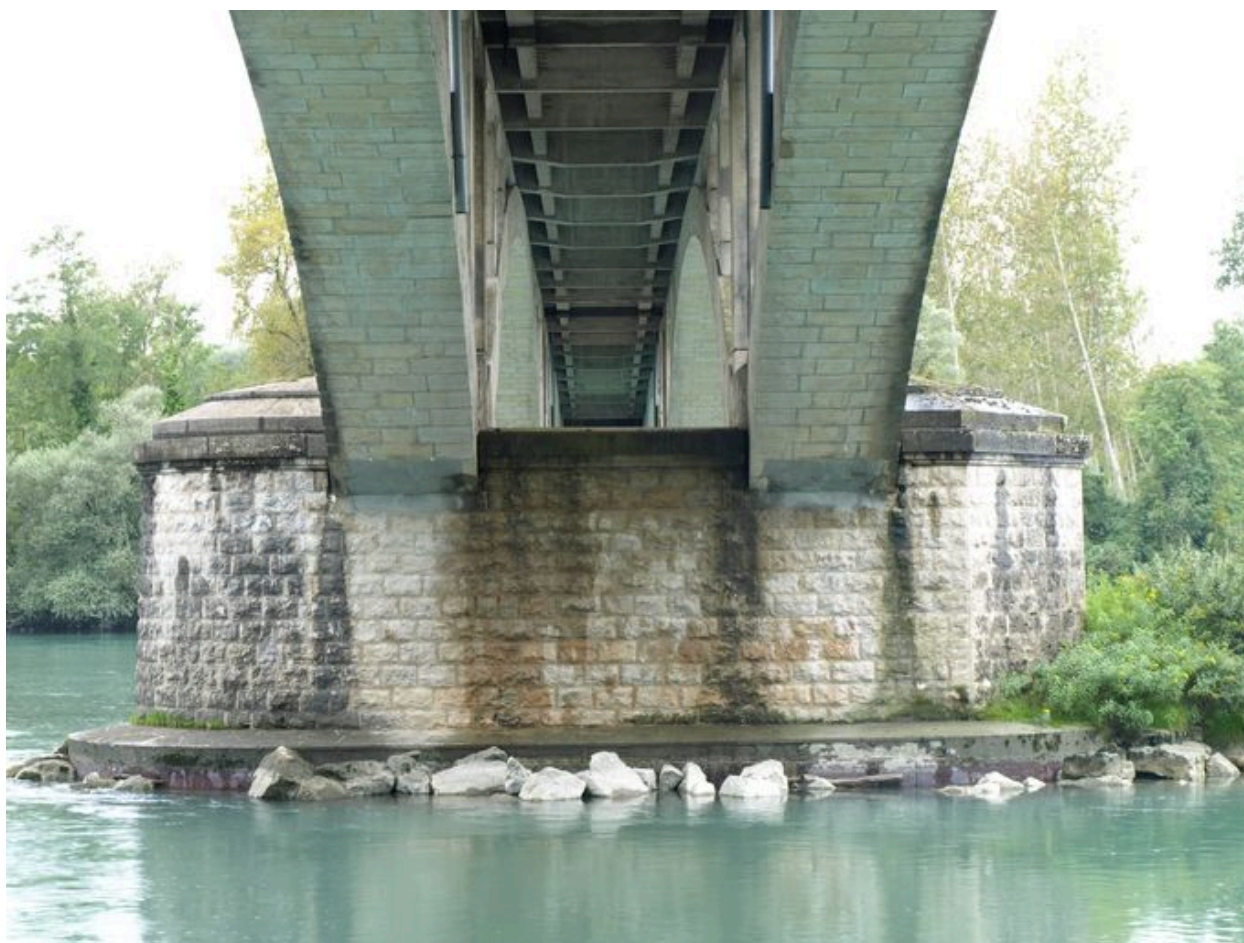
Pile (depuis la rive droite)
