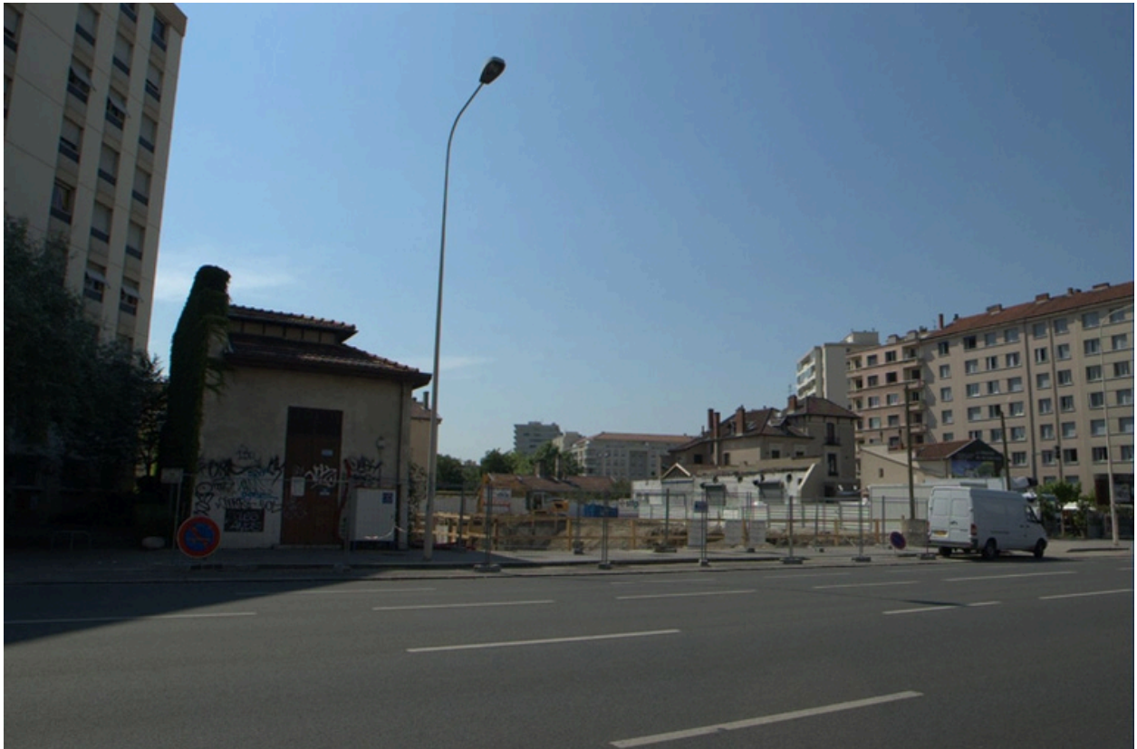
Vue d'ensemble après démolition des ateliers sheds
