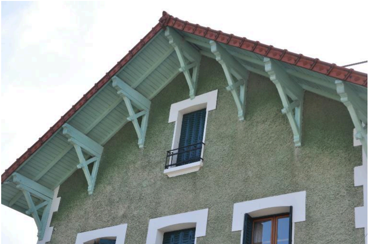
Aisseliers soutenant l'avant-toit
