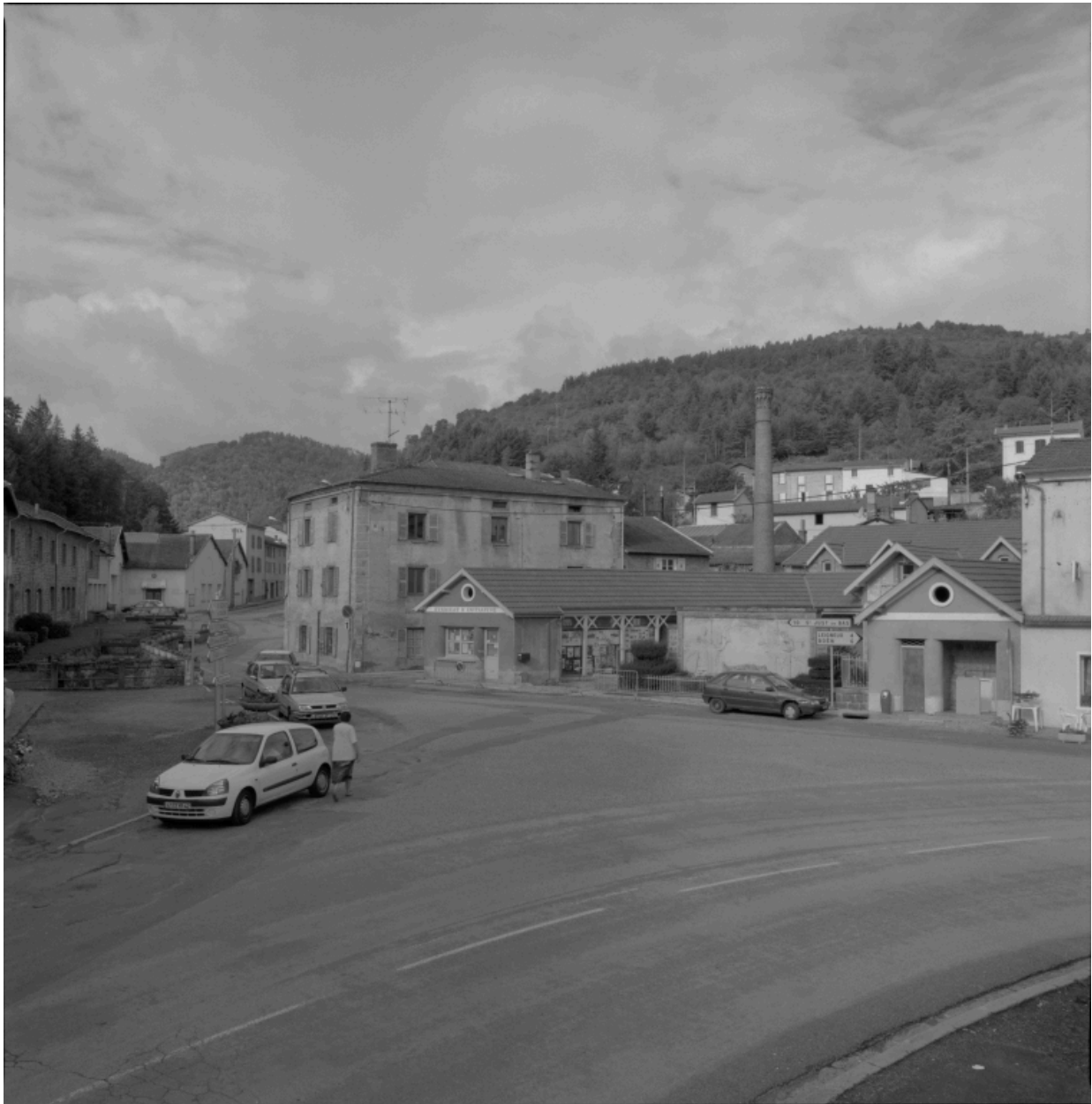
Vue générale des bains - douches et de la cheminée.
