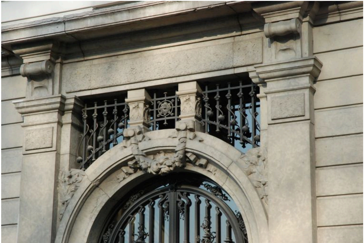
Détail de l'entrée située 2 place Ollier.
