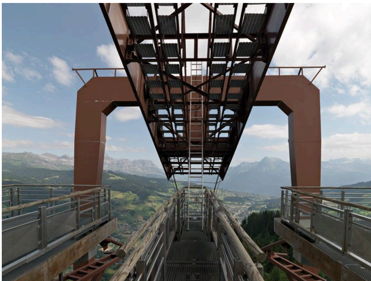
Gare supérieure. Portique et rails de portage des câbles
