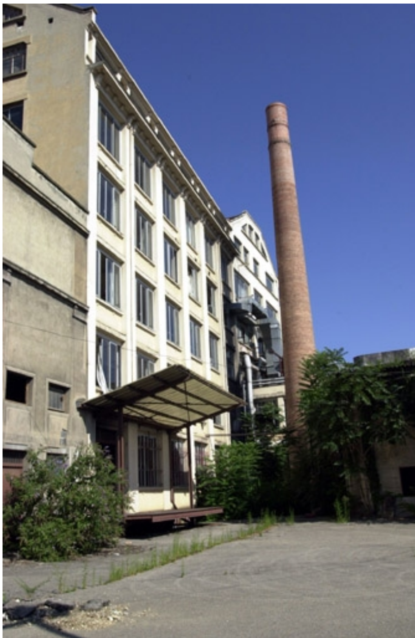
Vue de la cheminée avant la démolition
