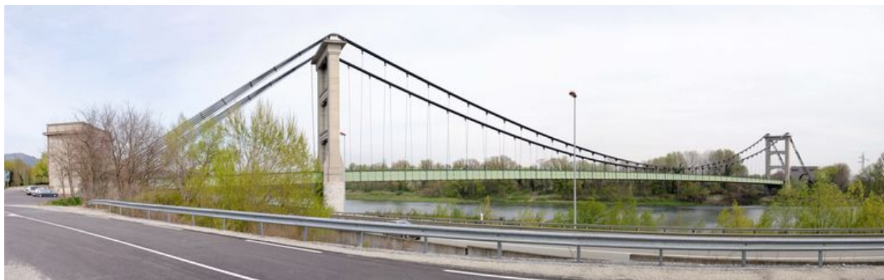
Vue panoramique, côté aval (depuis la rive droite)
