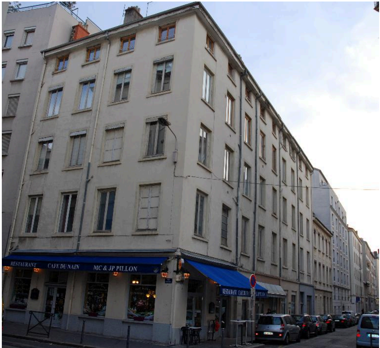
Vue d'ensemble depuis la rue Cavenne
