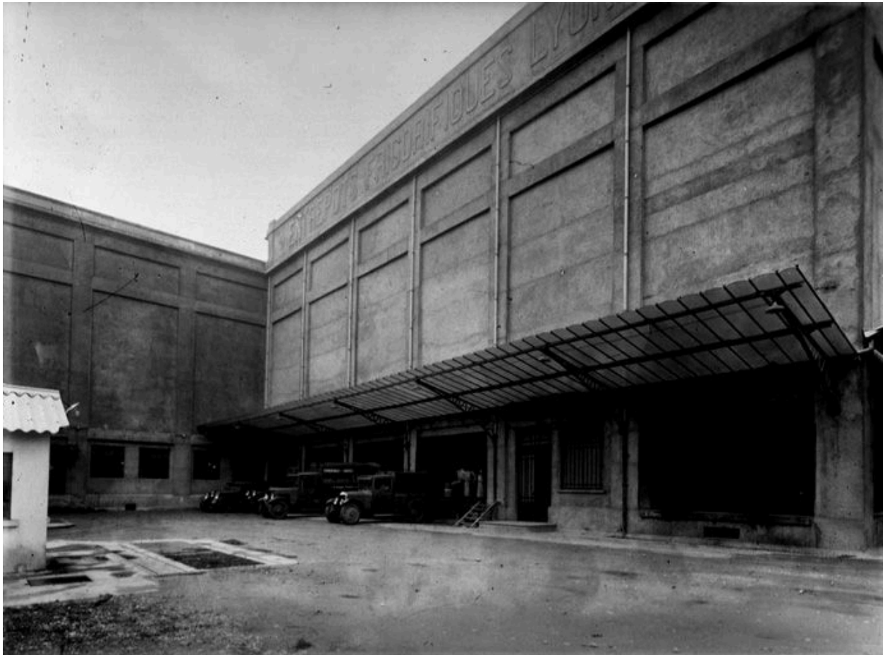
Façade avec enseigne 1930 (BM Lyon)
