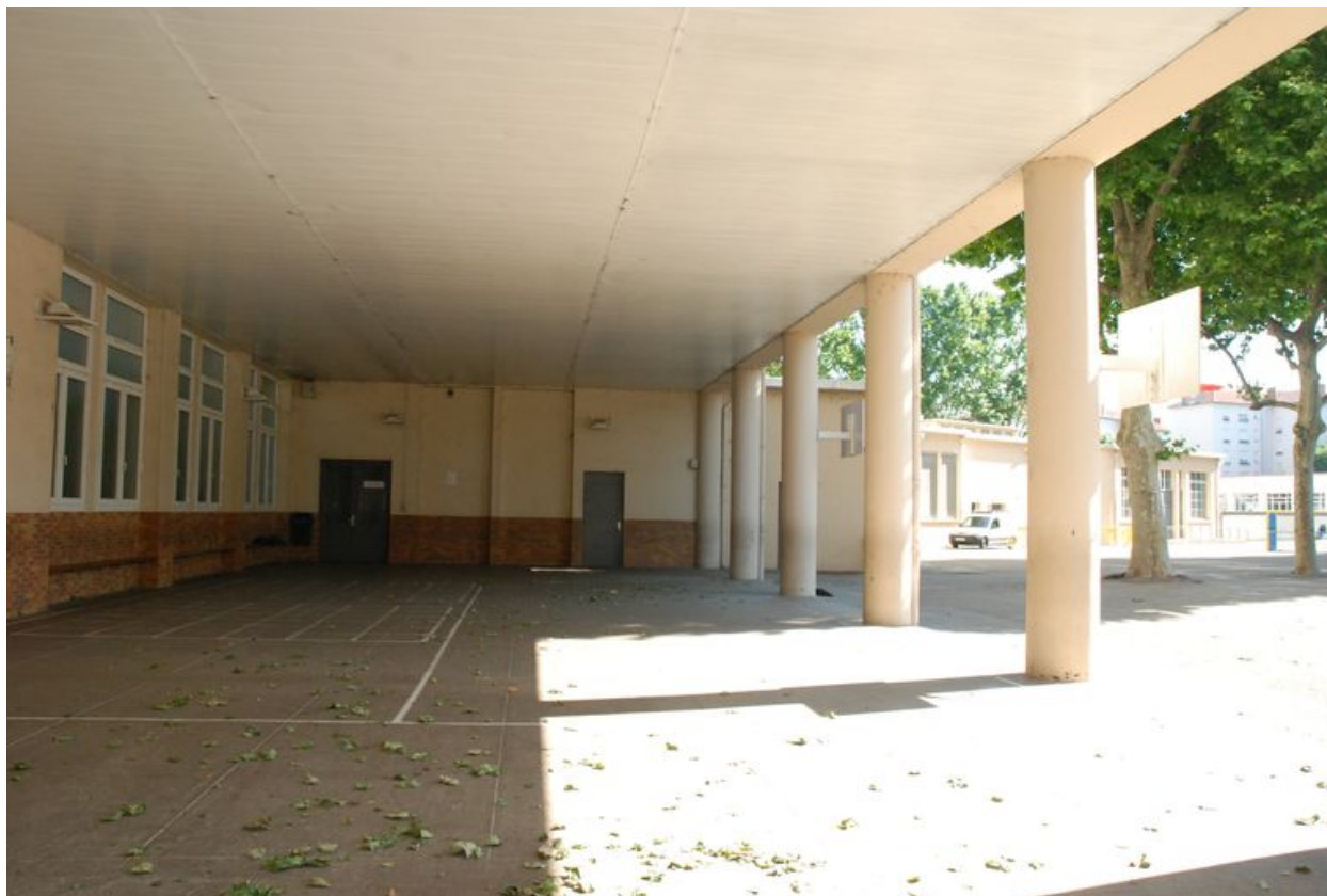
Vue du préau sud-est
