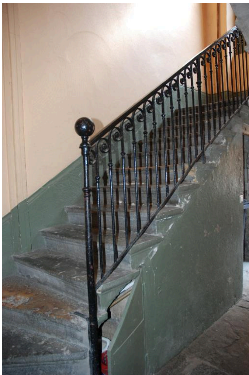
Vue du départ de l'escalier
