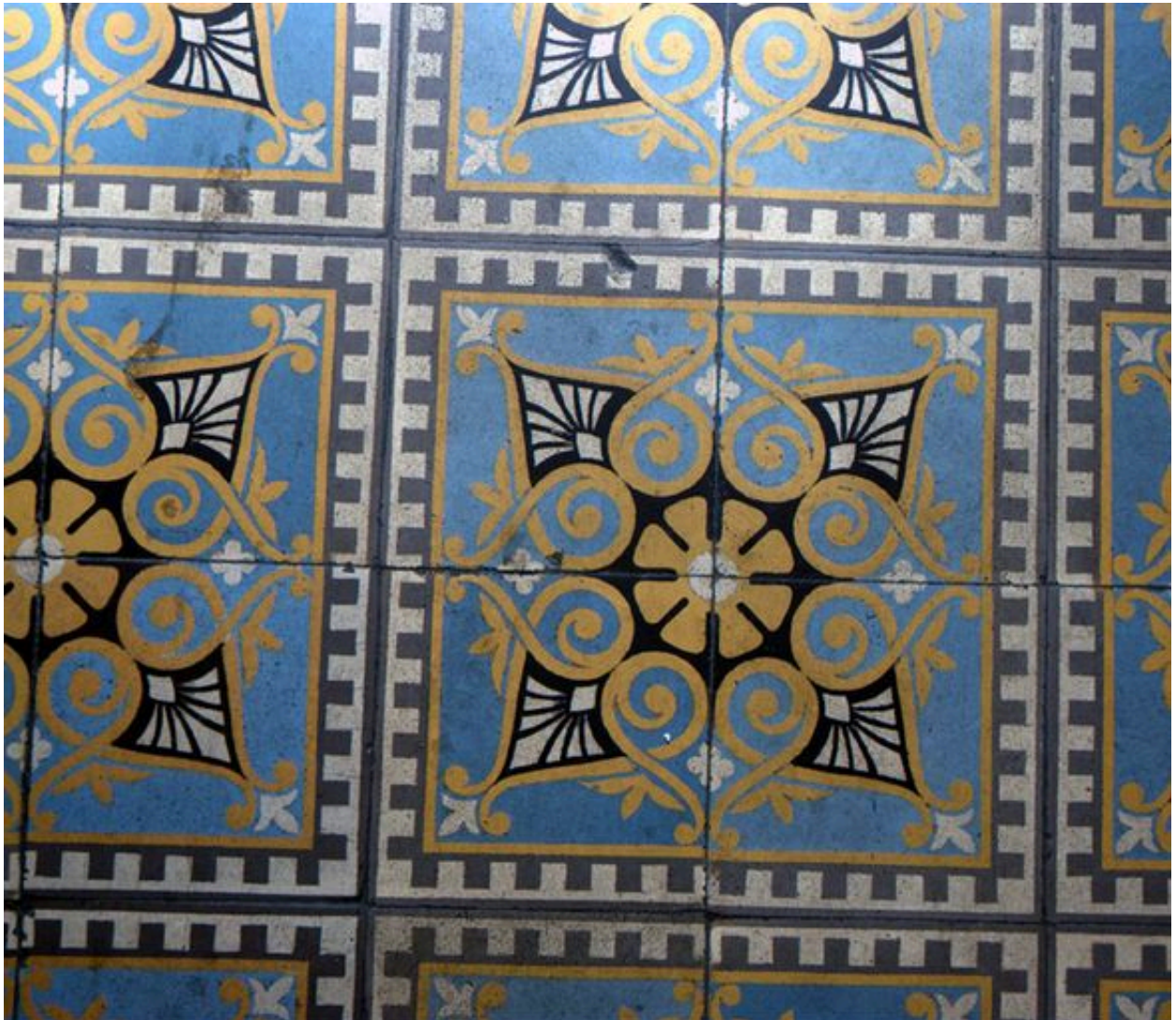
Détail du carrelage du vestibule
