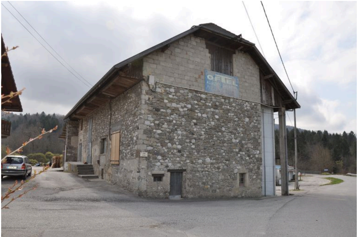
Mur pignon ouest du bâtiment de la minoterie
